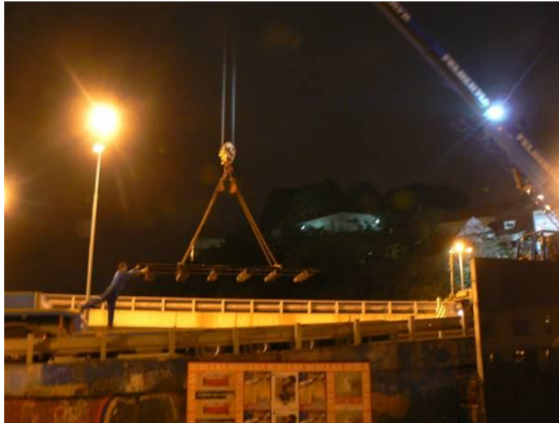
Nakladanie koľajového poľa.
